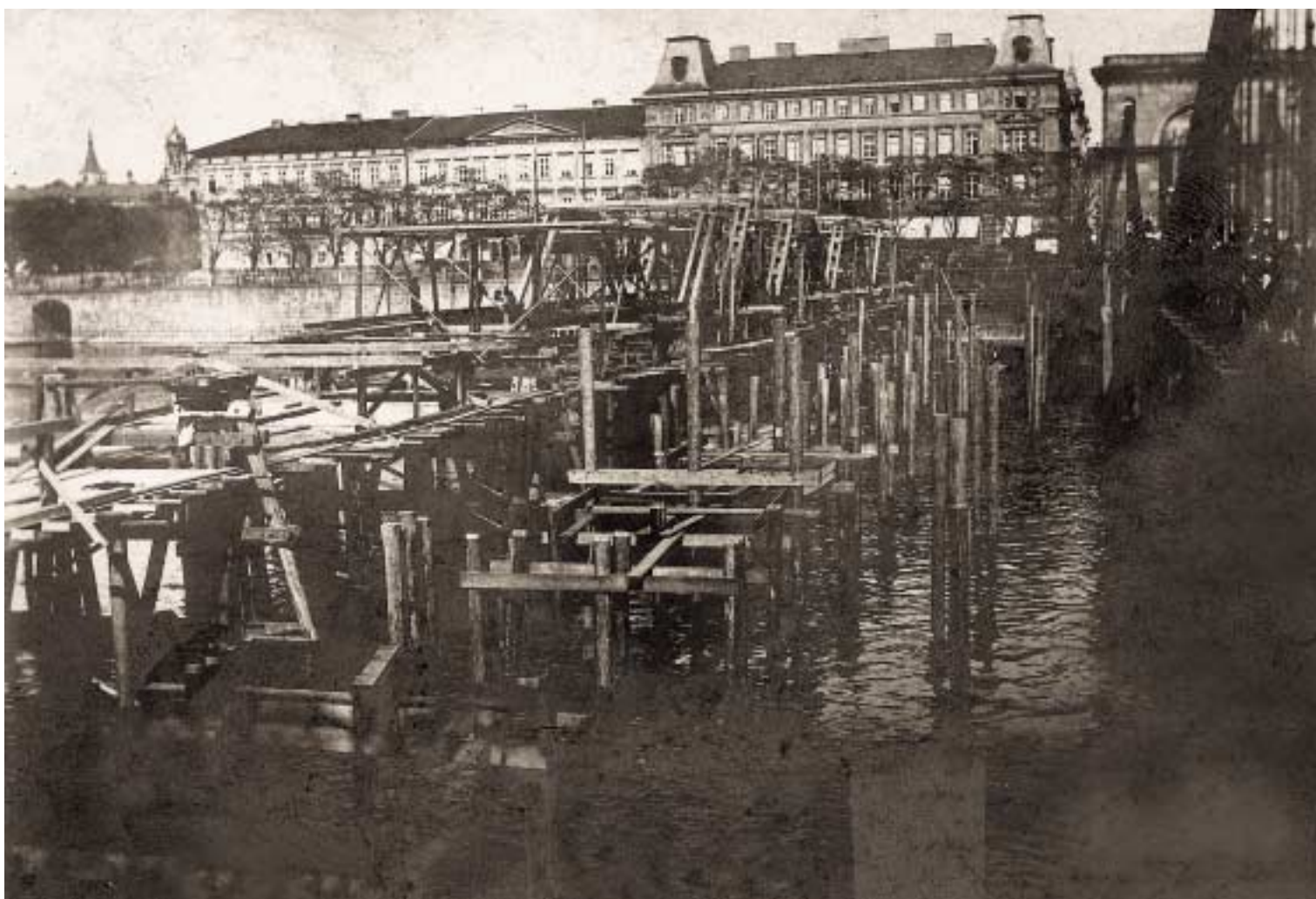
Stavba kamenného mostu Františka Josefa I. V pozadí palác Lažanských, od roku 1881 sídlo nové kavárny Slavia. Fotografie z roku 1901.
